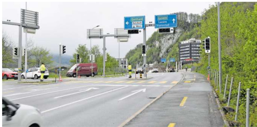
Die Lichtsignalanlage bei der Autobahnausfahrt und -einfahrt Stans Nord ist zurzeit ausser Betrieb.
